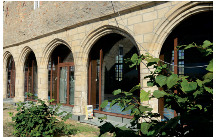
Agrandissement des ouvertures du réfectoire pour plus de luminosité
