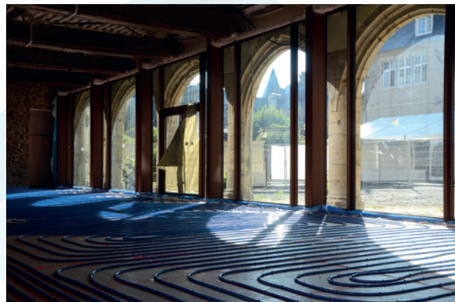
Installation d'un chauffage au sol dans le réfectoire
