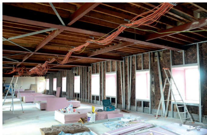
Service administratif en cours de rénovation
